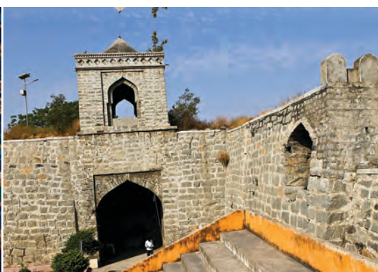
रायचूर दुर्ग की चिनी हुई दीवार Wall made of ashlar masonry, Raichur fort
